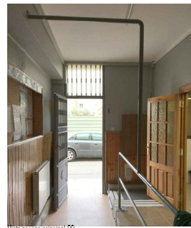
Vista acceso principal PB.
