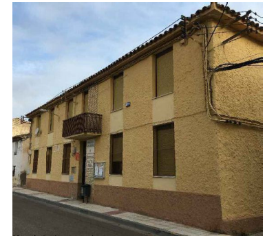
Vista fachada principal.
