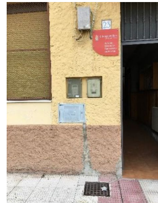
CONTADORES ELÉCTRICOS Y AGUA
