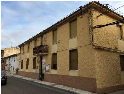
VISTA FACHADA PRINCIPAL DESDE CALLE IGLESIA
